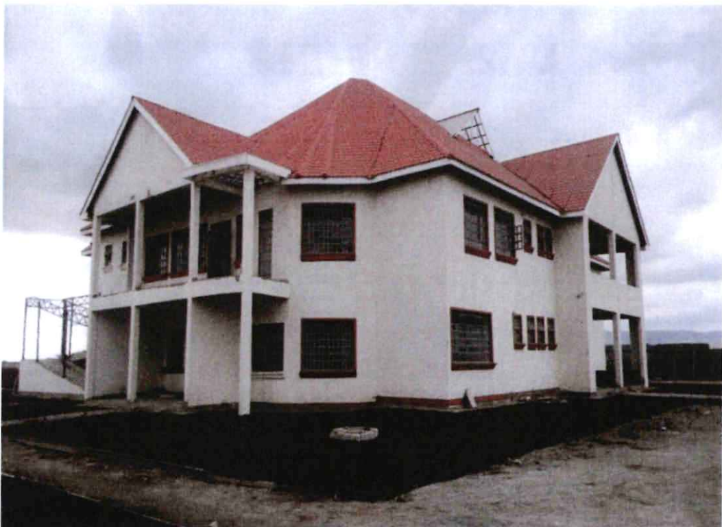
Photo 24: CWSK Joska: Maisonette 2 progress
