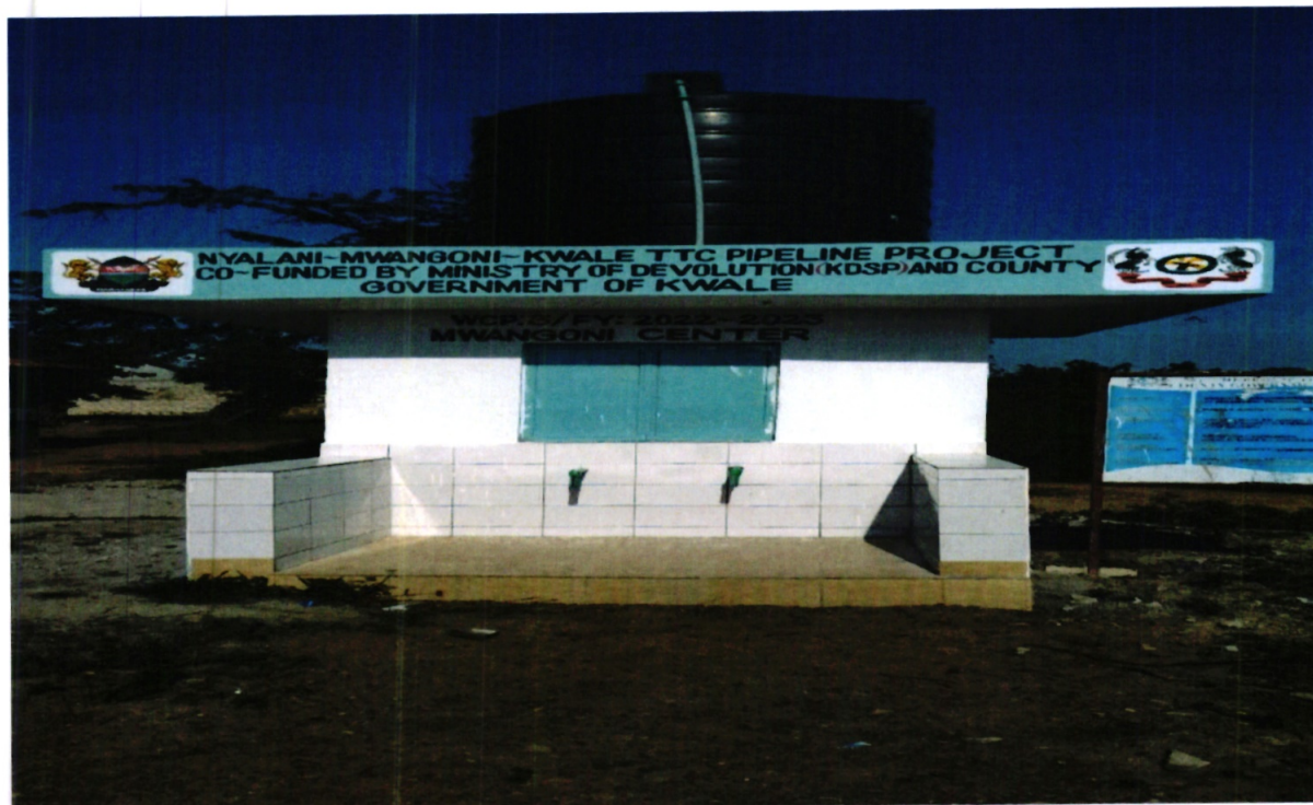
Nyalani Mwangoni Pipeline
