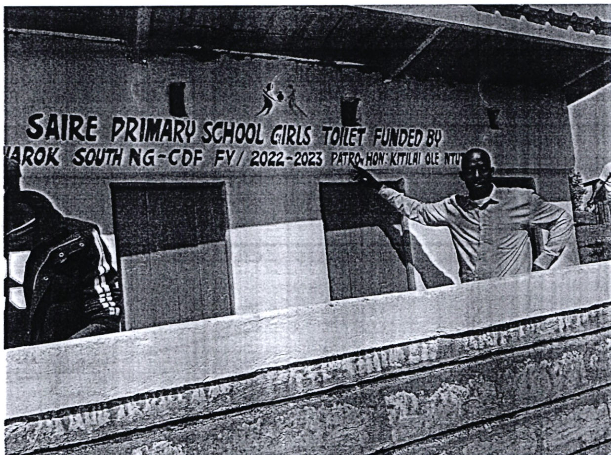
SAIRE PRI SCHOOL-TOILETS
