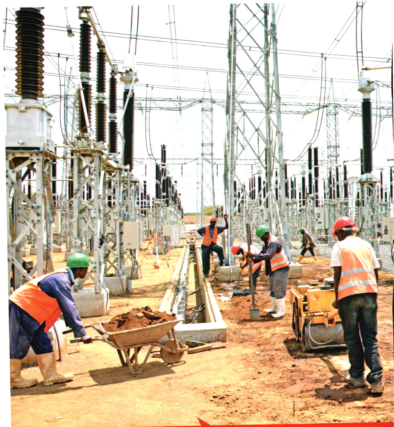
Kazi ya ujenzi katika kituo cha Suswa
