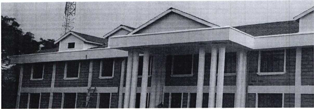
Suba North NG-CDF Office: Construction of Office
