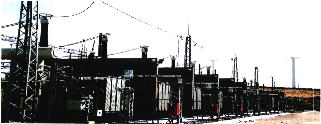
300MW Lake Turkana wind Power Project
