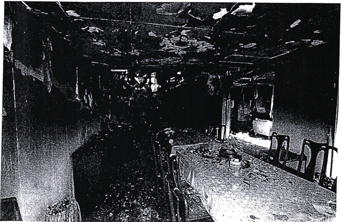
写真 2 は、第 1 図の 1 → の位置から、食堂から台所方向を撮影したもの
