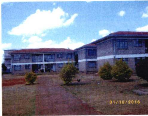
Flat done under Moody (Kamiti)
