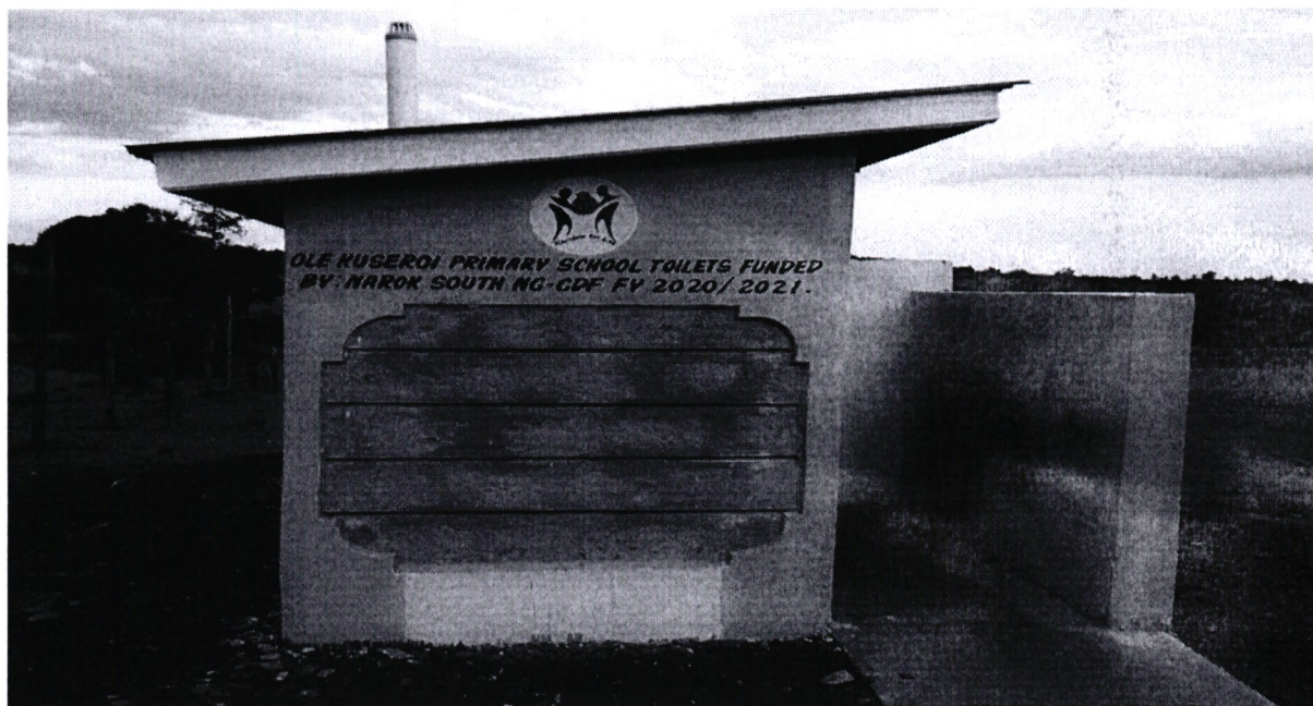
OLE KUSEROI PRI SCHOOL-TOILETS
